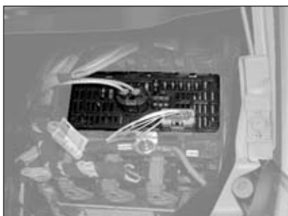
Fusibles bajo capó motor
